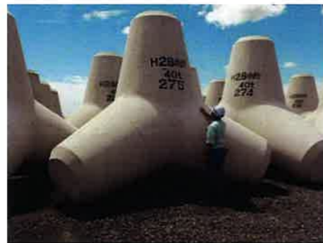
国土交通省東北地方整備局発注 仙台塩釜港石巻港区雲雀野地区南 防波堤 (40t 級消波ブロック)
