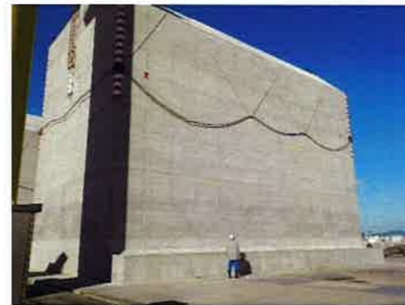
国土交通省東北地方整備局発注 仙台塩釜港石巻港区雲雀野地区 南防波堤 (ケーソン)
