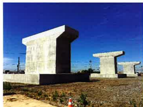
宮城県発注 石巻市鎮守大橋下部工工事 (橋脚)
