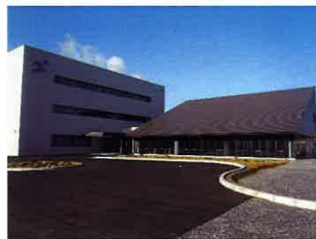
日本製紙石巻工場 事務所新設工事 (基礎・土間)
